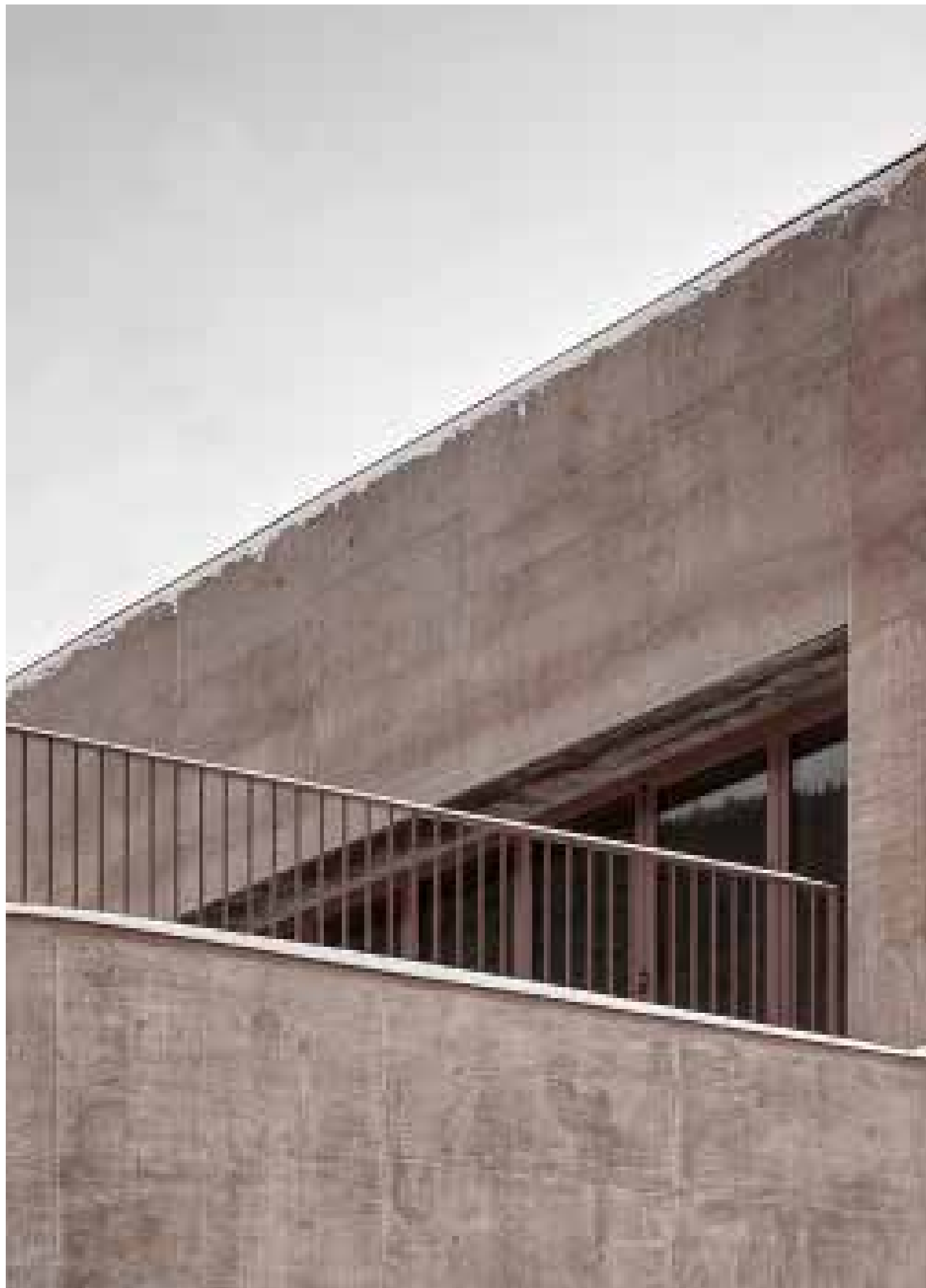
Auf 1.130 Höhenmeter steht das Feuerwehrhaus Vierschach – im östlichen Hochpustertal.
