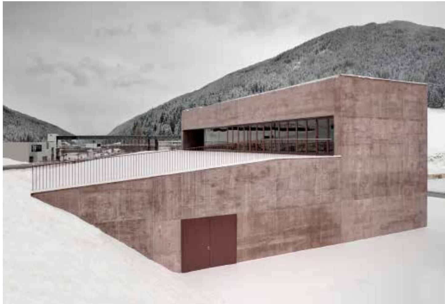
Erkennbar massiv: 60 Zentimeter starke Wände trennen Innen- von Außenraum.
